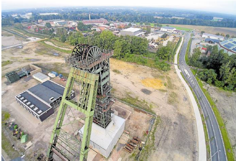
Aktuell wird die Wasserhaltung auf Fürst Leopold zum Reservestandort umgebaut.
