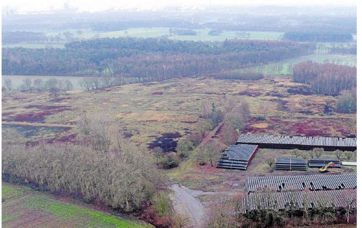
Auf dem ehemaligen Zecheareal in Wulfen ist die Entwicklung des Industrieparks Große Heide geplant. Derzeit lagern dort noch Rohre für die neuen Open-Grid-Gasleitungen. FOTO BLUDAU
