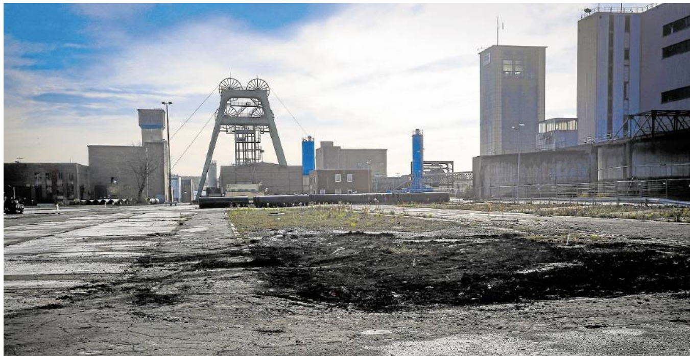
Auf dem Gelände der Zeche Auguste Victoria 3/7 in Marl soll in den nächsten Jahren ein Gewerbepark entstehen. Dafür wird auch die ehemalige Kohlenwäsche (r.) weichen müssen. FOTOS (2): STEPHAN SCHÜTZE
