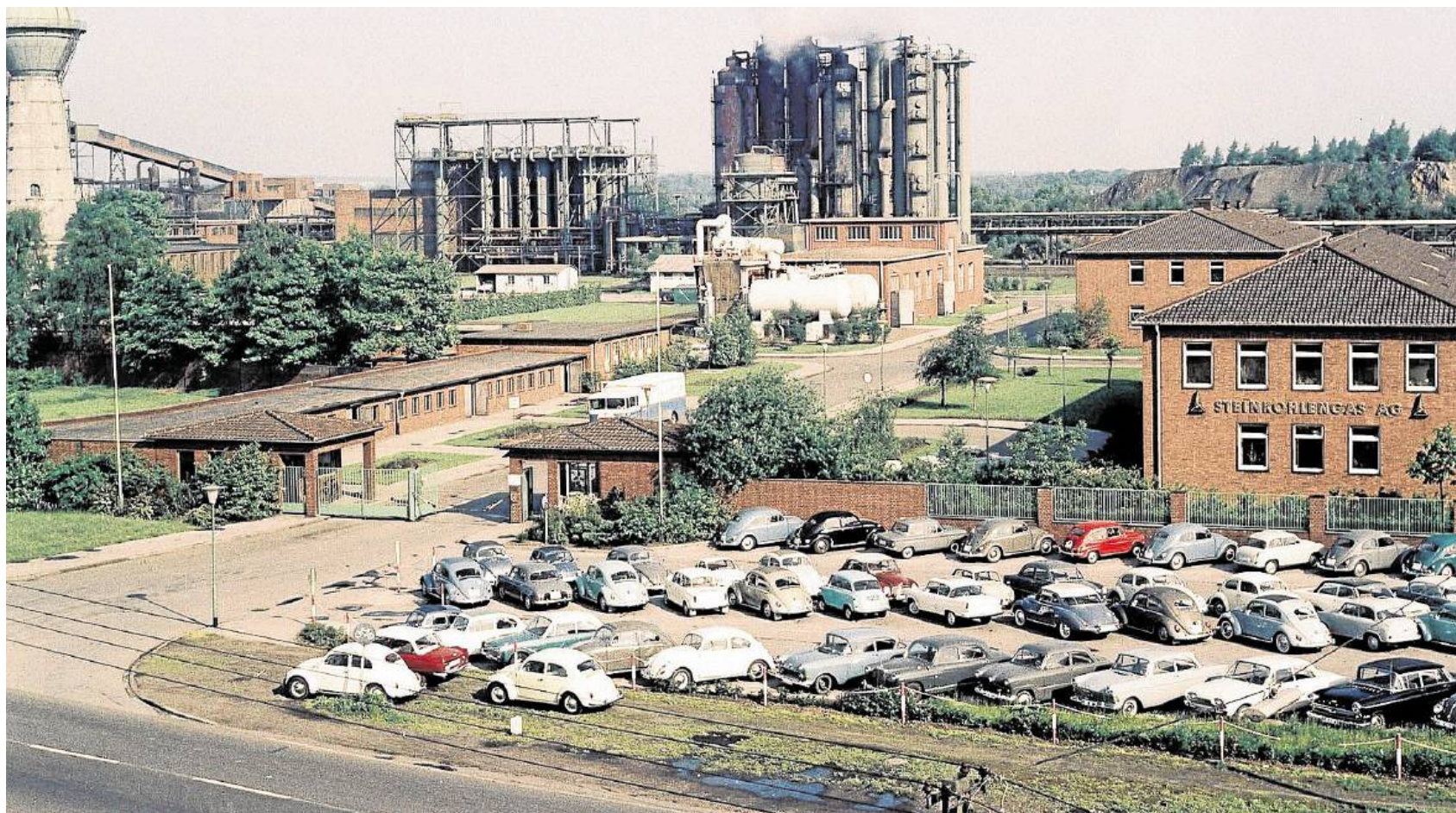
Lang ist es her: Blick auf die Steinkohlengas-Anlage von der Halterner Straße aus.
