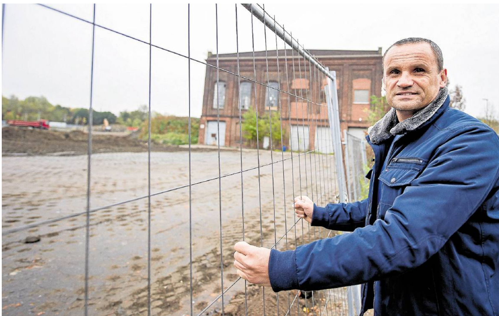
Martin Max fuhr in der Zeche General Blumenthal noch selbst ins Bergwerk ein. Das Gelände erinnert heute jedoch kaum noch an die Zeit, in der hier Kohle gefördert wurde, nur das Maschinenhaus ist noch erhalten. FOTO INDERLIED
