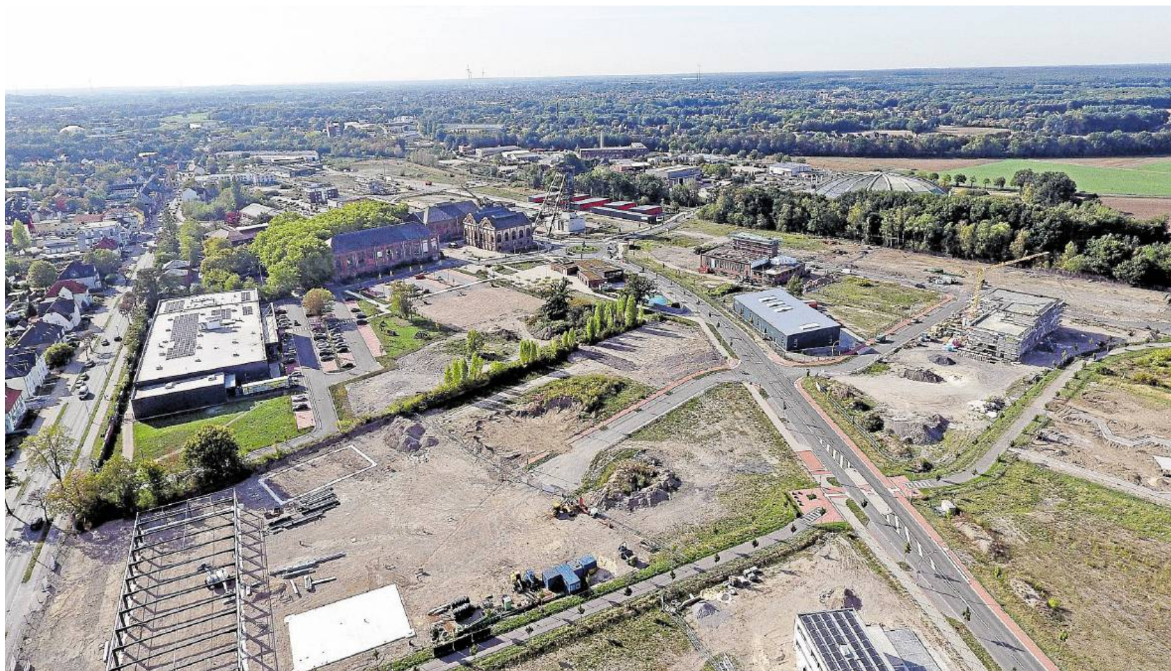
Das Zechengelände von Oben. Links haben die Rohbauarbeiten der Firma Oftec begonnen. Auch die benachbarten Flächen rechts Richtung Norden hat die städtische Wirtschaftsförderungsgesellschaft Windor inzwischen verkauft.
