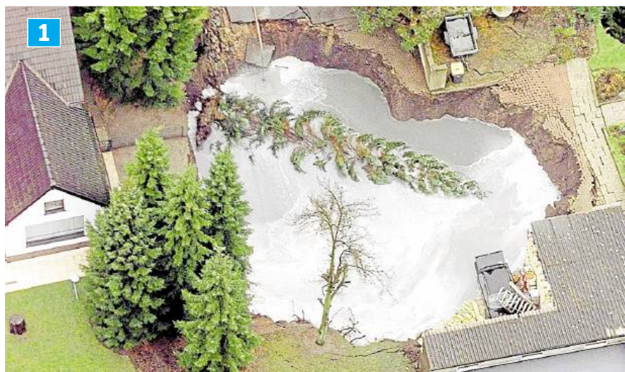
Das Höntroper Loch ist der bis heute wohl spektakulärste Tagesbruch in NRW. In dem Bochumer Stadtteil sackte der Boden im Jahr 2000 weg.
