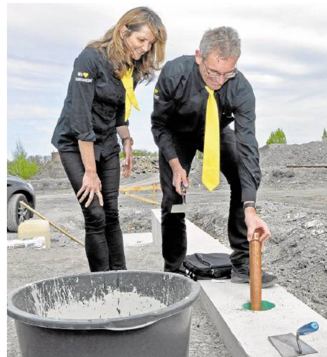
Martina und Ralf Honsel versenken die Zeitkapsel mit den örtlichen Zeitungen, aktuellen Geldmünzen und einem Bild der Bauherrenfamilie Honsel in dem dafür vorgesehenen Fundamentloch, das danach zubetoniert wurde.
