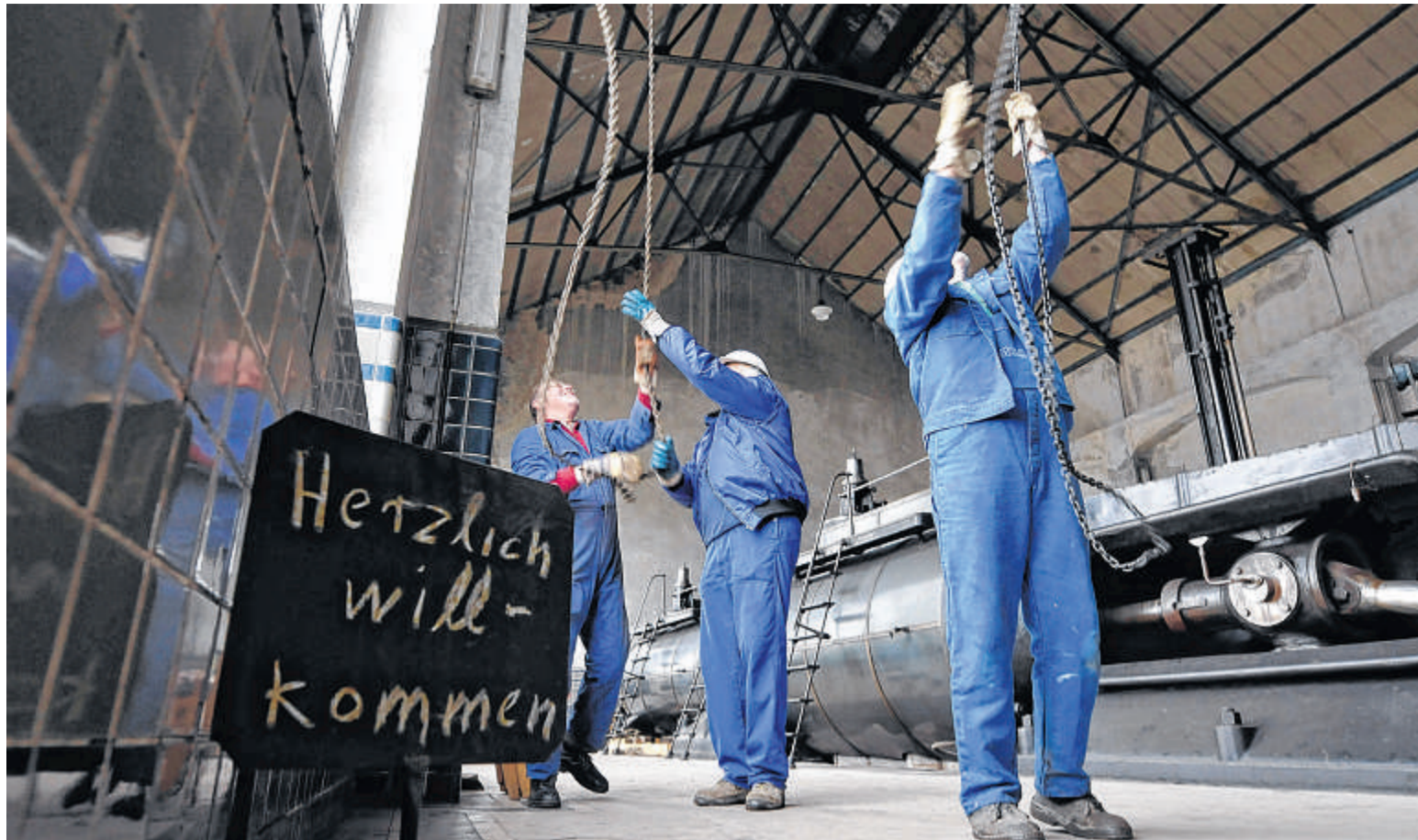
Die Renovierungsarbeiten im Maschinenhaus – hier die von Gerhard Schute genannte Aufnahme – hat die WAZ über Jahre begleitet.
