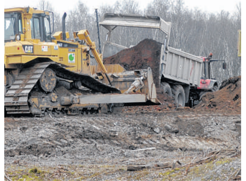
Kipper bewegen den Abraum über das Zechengelände, Walzen verteilen den Boden an seinem endgültigen Platz. FOTO: ANDRÉ ELSCHENBROICH
