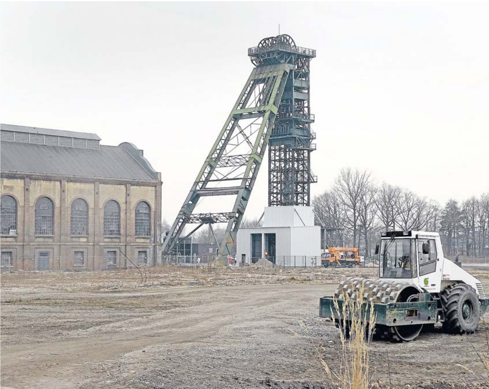
Nur noch ein Förderturm und einige ehemalige Zechengebäude werden von der Zeche Fürst Leopold erhalten bleiben.
