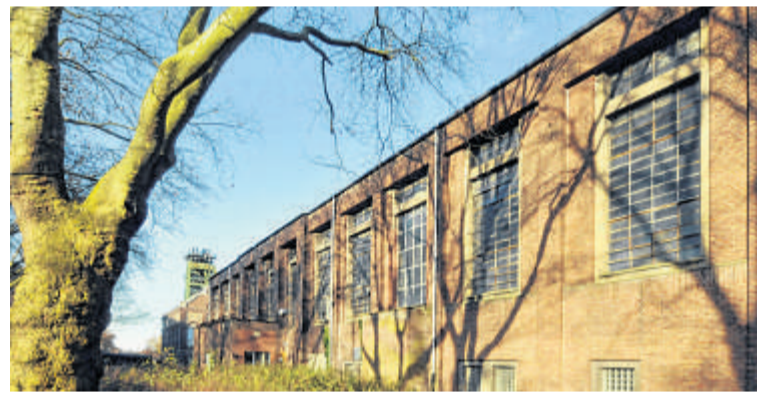
Im Untergeschoss Dampfdruckzentrale entsteht eine „Sportsbar“. FOTO: MEINERT
