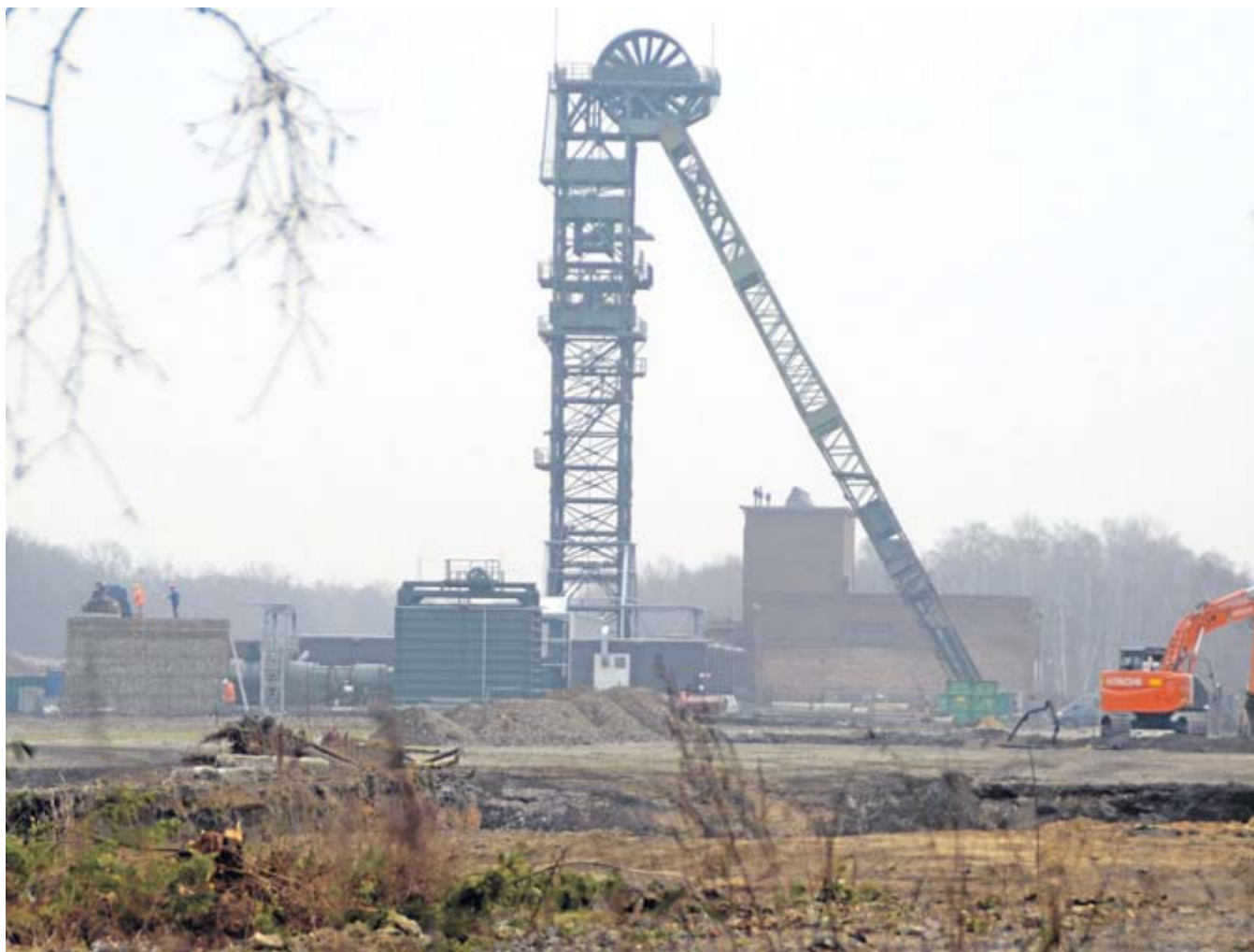
Die Bodenaufbereitung der ehemaligen Zechenfläche „Fürst Leopold“ hat begonnen. Die ausführende Gesellschaft RAG-Montan rechnet damit, die westlichen Teile des Zechengeländes bis Mai saniert zu haben. RN-Foto Eggert
