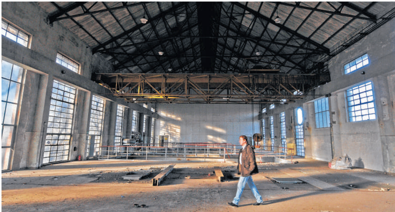
Für alte Dampfdruckzentrale des ehemaligen Bergwerks Fürst Leopold sucht Ralf Ehlert noch nach einem schlüssigen Konzept.
