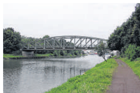
Die Tage der alten Hervester Brücke sind gezählt. FOTO: WASSER- UND SCHIFFFAHRTSAMT
