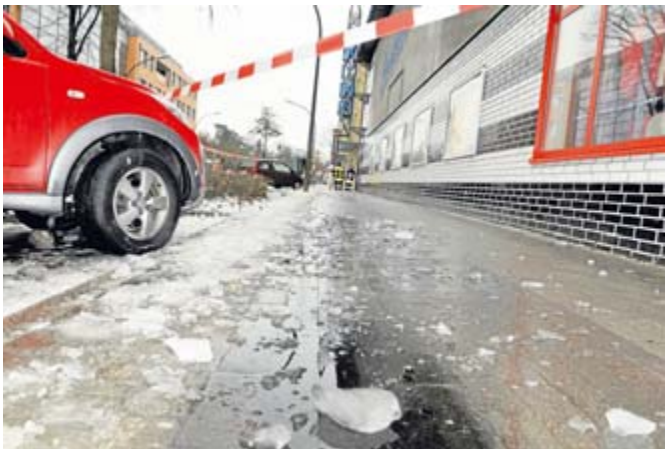
Dicke Eisbrocken fielen in Holsterhausen aufgrund des Tauwetters vom Dach.
