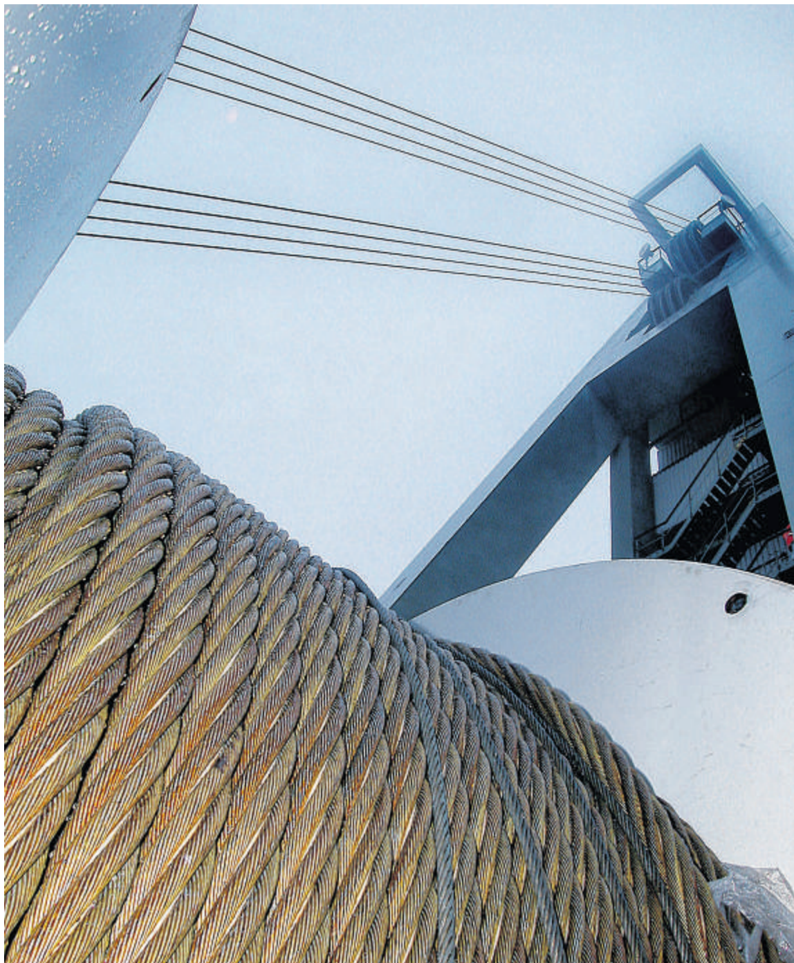
Das Bergwerk Prosper Haniel baut in zwei Betrieben unter der Kirchheller Heide ab.
