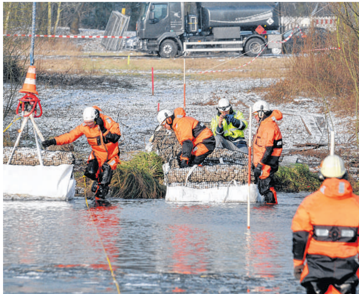
Mit Überlebensanzügen und Schwimmweste sind die Männer gesichert, die in dem ca. 60 cm tiefen Wasser arbeiten müssen. Vereinzelt gibt es Kühlen, in die die Männer plötzlich bis zur Hüfte ins Wasser abrutschen können.
