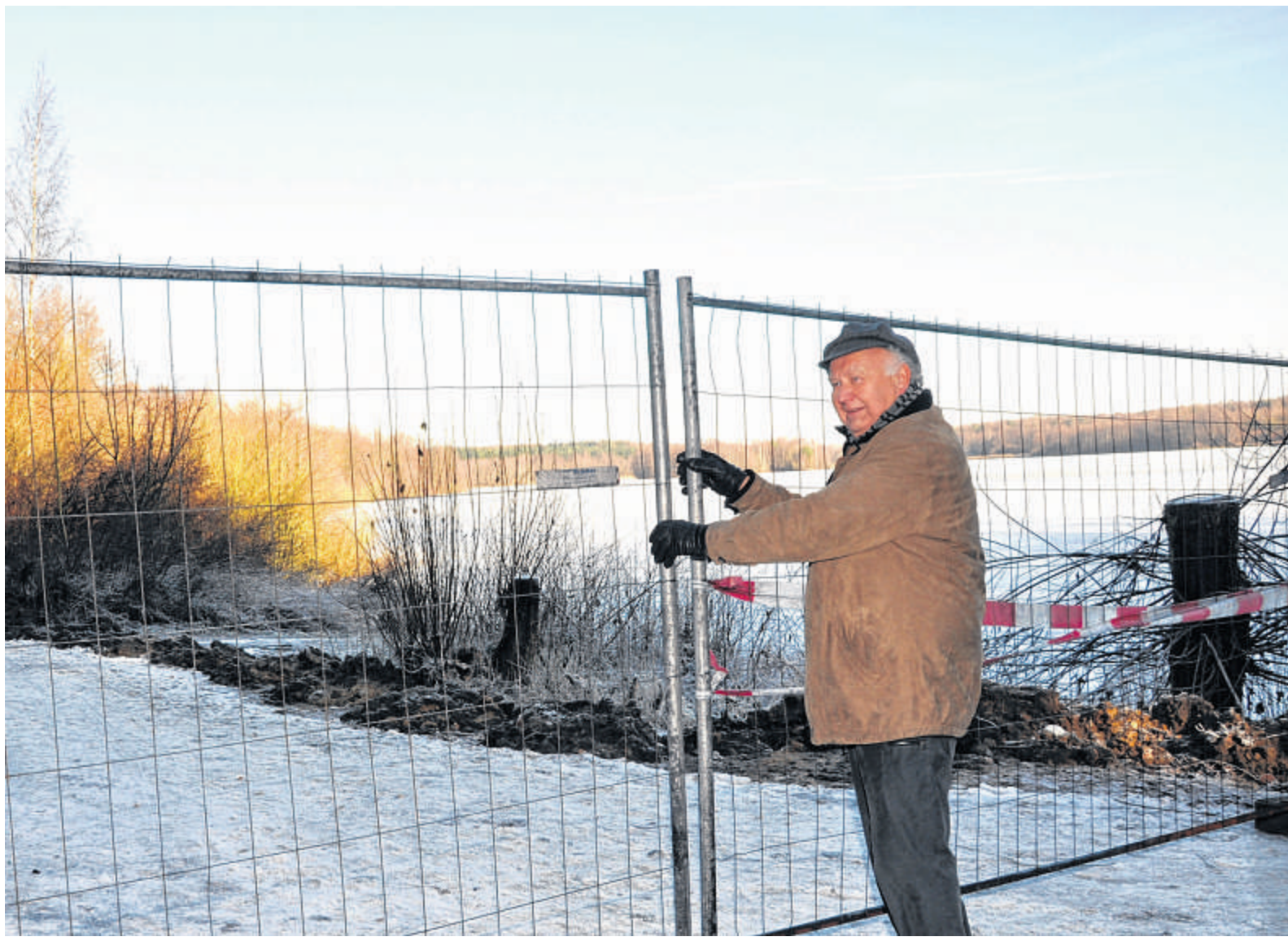
Am Heidensee wurden Spundwände installiert, weil der See durch Senkungen kippt. Theo Stricker aus Grafenwald konnte nicht mehr um den See gehen. FOTOS: FRANZ NASKRENT
