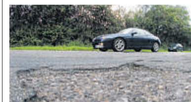
Die Heidener Straße wird ab heute gesperrt und saniert. FOTO: ELSCHENBROICH
