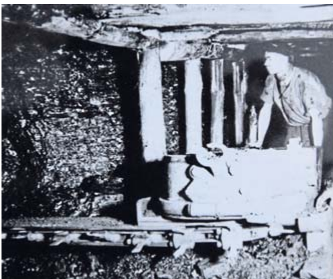
Die Vorbereitung zum Kohleabbau mit einer Schrämmmaschine. Foto privat
