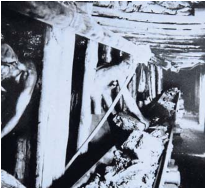
Die Abförderung der Kohle auf einer „Schüttelrutsche“ im Streb. Foto privat
