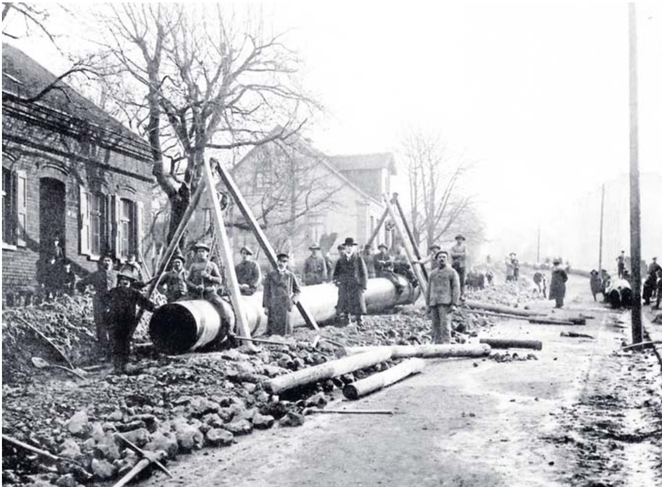
Rückblick in eine Zeit, als fließendes Wasser noch keine Selbstverständlichkeit war: Rohrleitungsarbeiten im Jahre 1904.
