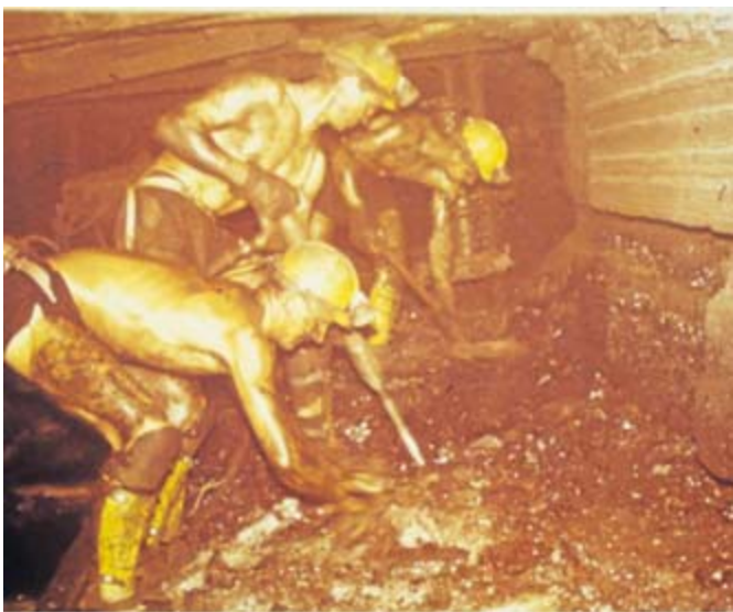
Kumpels bei der Arbeit mit dem Kohlehammer.
