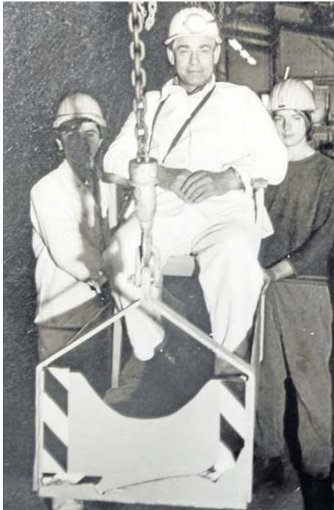
Eine Seilbahn unter Tage. Dieses Bild hat uns Johannes Botterbrod zur Verfügung gestellt.
