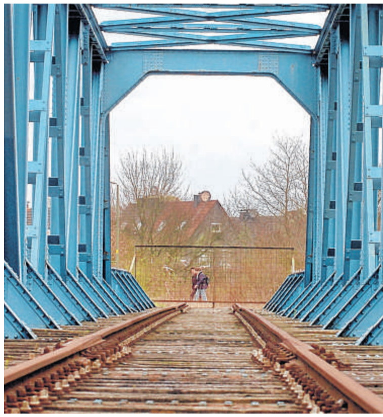
Der Ausbau der ehemalige Zechenbahn zum Fuß- und Radweg soll im nächsten Jahr beginnen.
