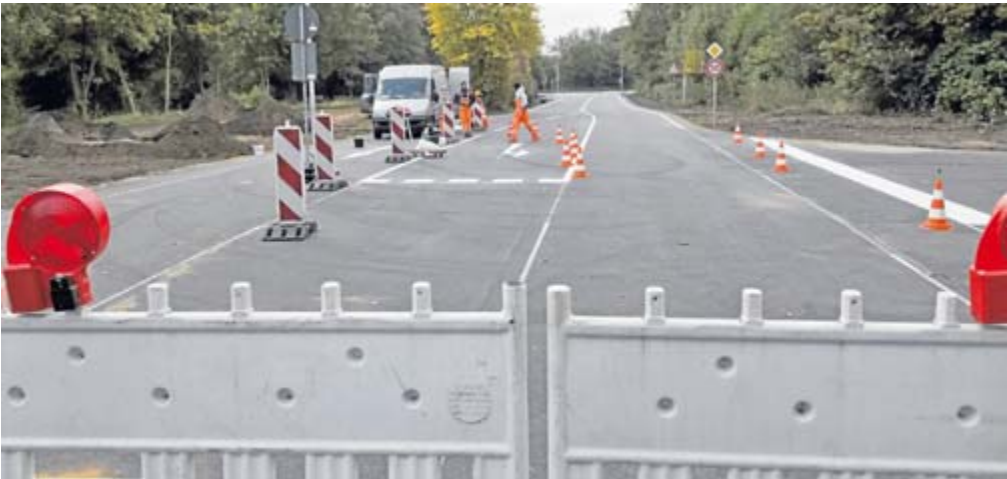
Letzte Markierungsarbeiten, dann wurde gestern Nachmittag ein wichtiges Teilstück des Wittenberger Damms freigegeben. RN-Foto Bludau
