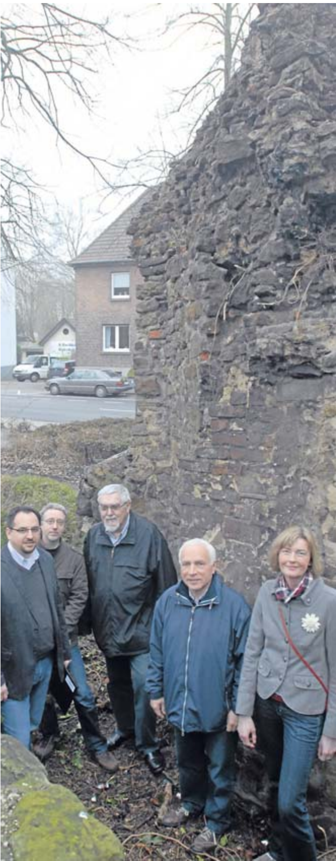
Jahrzehntelang befand er sich im Dornröschenschlaf, von Efeu blickdicht umrankt, von Bäumen verdeckt. Nun hat der Verein für Orts- und Heimatkunde dafür gesorgt, dass der Rest des mittelalterlichen Wach- und Wehrturmes am Westgraben freigelegt wurde. Federführend dabei war der Arbeitskreis Stadtbefestigung unter Leitung von Rene Franken (l.)
