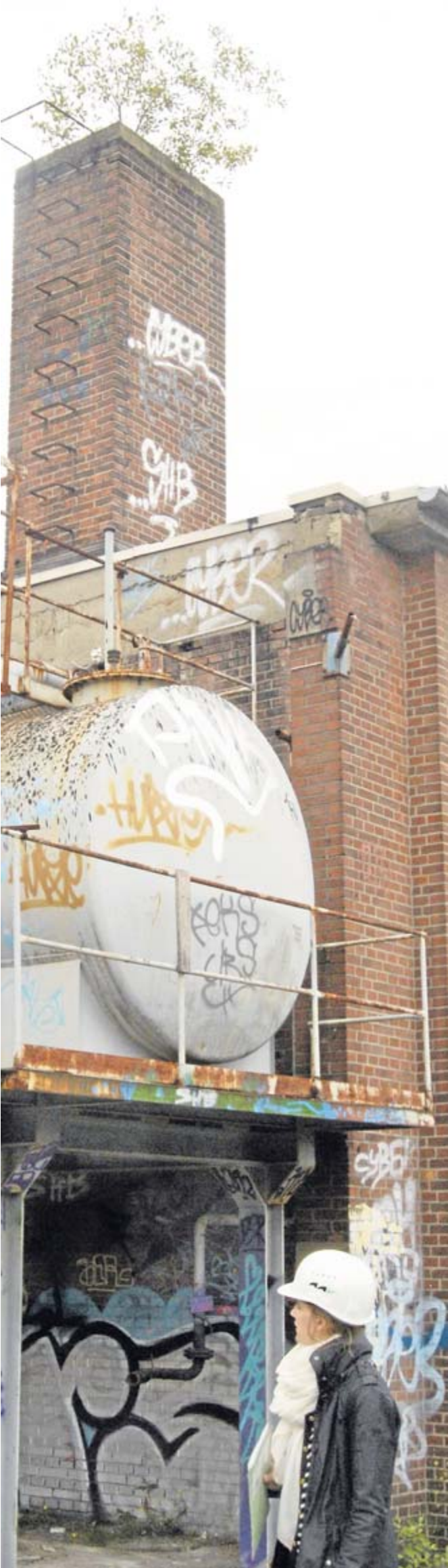
Aus dem Schornstein sprießt Grünes: Die Anlagen der Dachpappfabrik liegen schon sehr lange still
