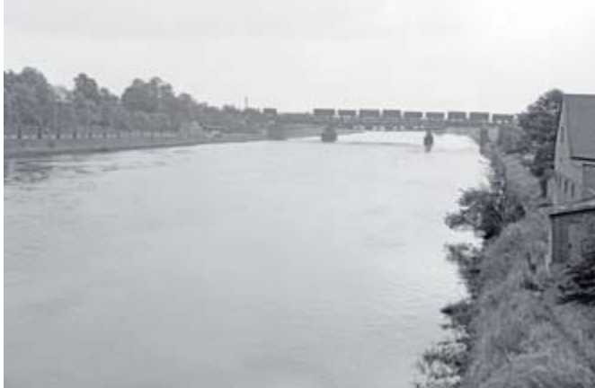
„Pegel Dorsten bei 480 cm!“ lautete am 28. September 1957 der Alarmruf. Die Fluten näherten sich bedenklich den Häusern am Ufer und der Bahnbrücke. Konsequenz daraus: 1962 begann der Bau des Lippedeichs.
