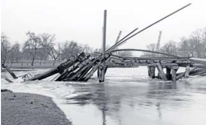
So viel Kraft hat die Lippe: 1939 riss sie bei Buddenburg ca. 50 km stromaufwärts von Dorsten eine Brücke nieder.
