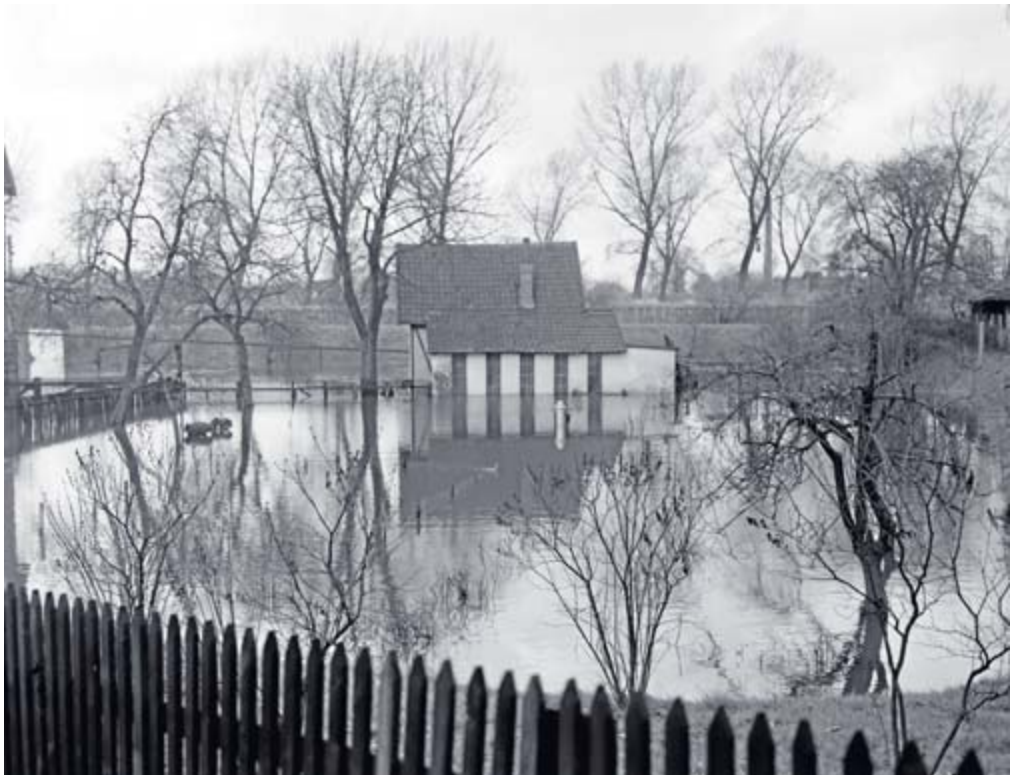
Ein Teich? Nein, Hochwasser an der Dorstener Kläranlage im Dezember 1960.
