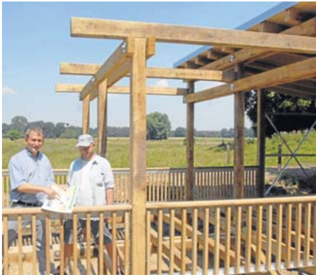
Jochen Ahlers (Projektleiter des Kreises) und Robin Mues (Planungsbüro Hoff) an der fast fertigen neuen Aussichtsplattform mit Blick aufs Storchennest. RN-Foto Klein
