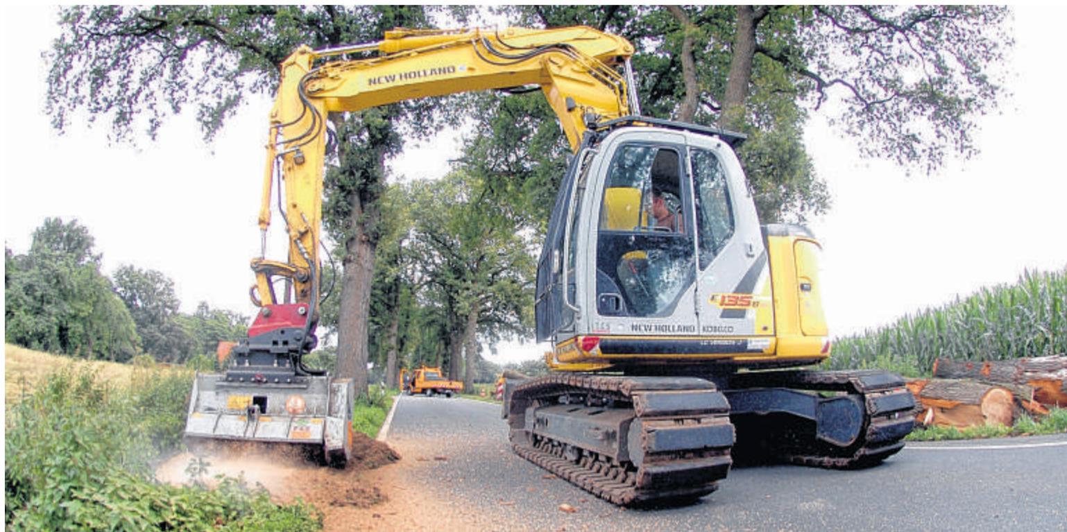
Ein Bagger in Aktion: Mit einem Aufsatz werden die Wurzeln der gefälltten Bäume geschreddert.
