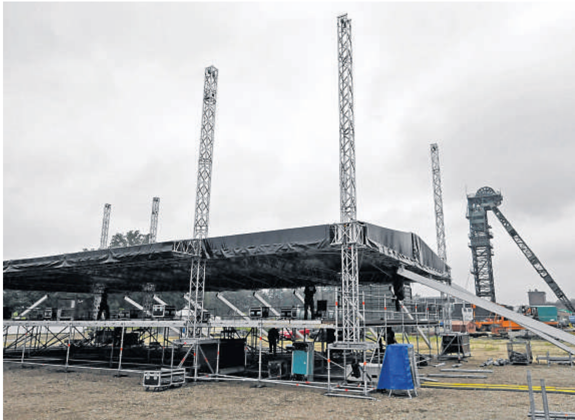
26 Meter breit, zwölf Meter tief und zehn Meter hoch ist die Bühne, die der WDR auf dem Festgelände an der Zeche aufgebaut hat. 14 Sattelzüge haben seit Montag das Material angeliefert. FOTOS: FRANZ MEINERT
