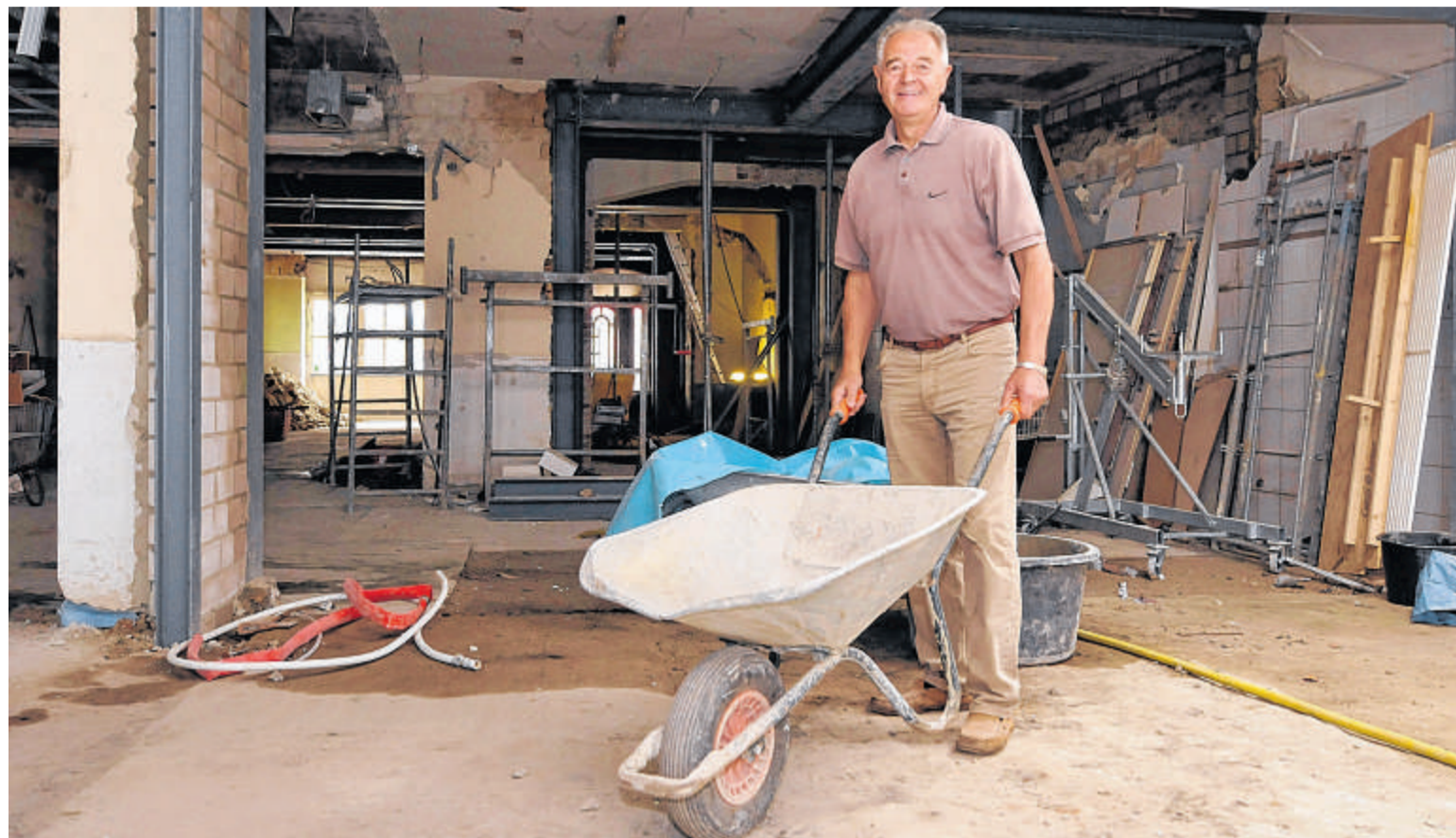
Bis Oktober ist noch viel zu tun: Hans Baumann auf der Baustelle der früheren „Stadtschänke“.
