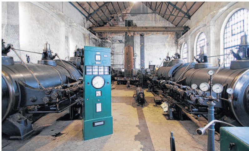
Nicht gefährdet: Der Umbau der Maschinenhalle mit den Dampfmaschinen der ehemaligen Zeche Fürst Leopold.
