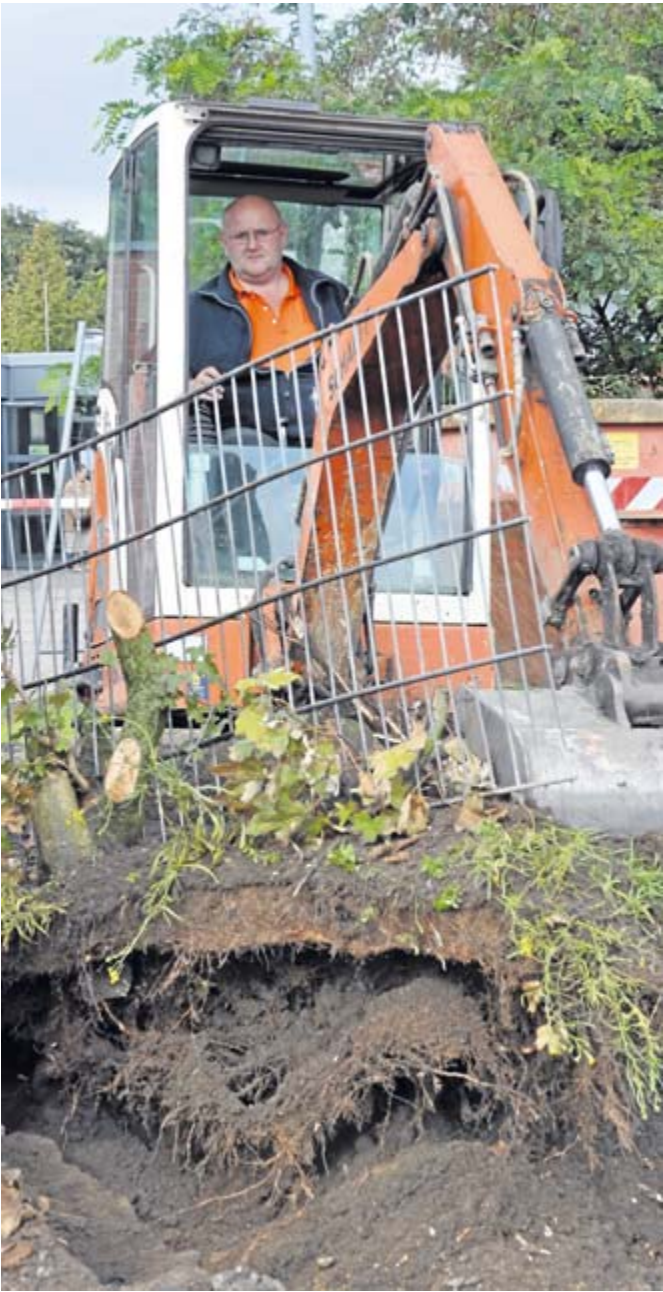
Sieben Parkplätze für das Jüdische Museum entstehen derzeit auf dem Gelände des Treffpunkt Altstadt.
