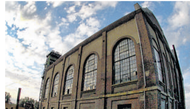
Der Bergbauverein berät heute abschließend über das Nutzungskonzept für das Maschinenhaus auf Fürst Leopold. Foto: Elschenbroich
