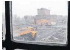
Blick aus dem Maschinenhaus auf die Kohleversuchsanlage.
