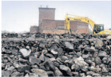
Vier Meter hoch liegt das Schotterbett, in das die Kohlenwäsche nach der Sprengung fallen soll.
