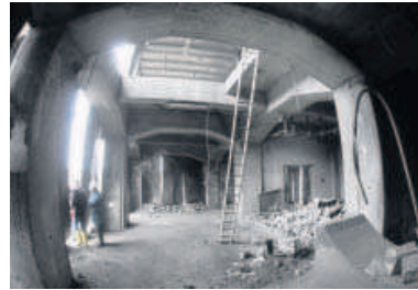
Blick ins Unterstübchen der Kohlenwäsche. Rechts am Pfeiler sind die Bohrlöcher für den Sprengstoff zu erkennen.
