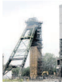
Der Fördertrum steht mittlerweile befreit von der Schachthalle da.
