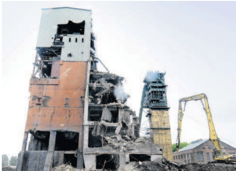
Eine Sprengung der unteren Pfeiler lässt am Mittwoch die Kohlenwäsche (52 Meter hoch) umkippen.
